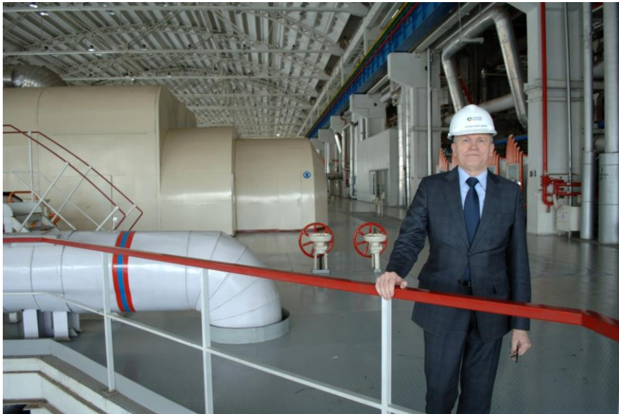
Kauno hidroelektrinės mašinų salė po rekonstrukcijos
