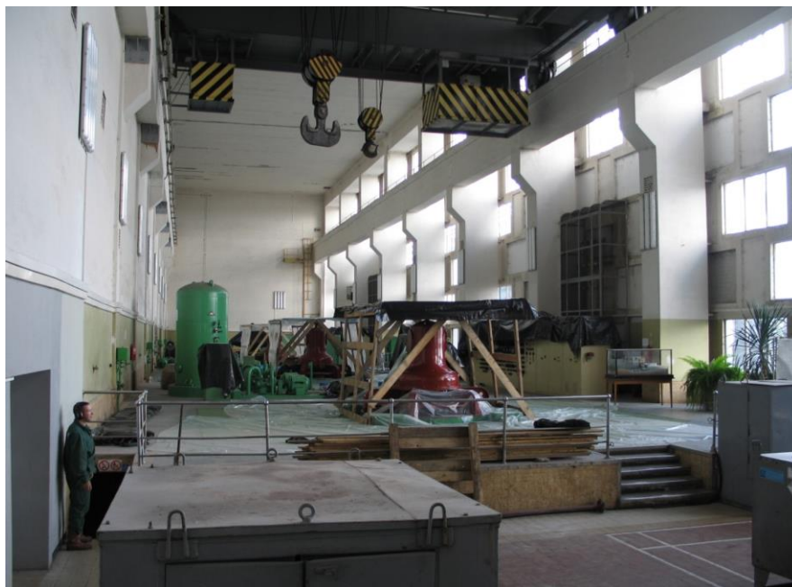
Kauno hidroelektrinės mašinų salė prieš rekonstrukciją
