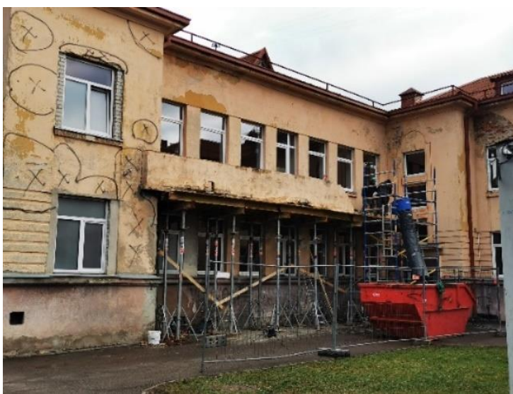
13 pav. Aklyųjų instituto fasadų remonto darbai. 2023m. Šaltinis: sudaryta autorės
