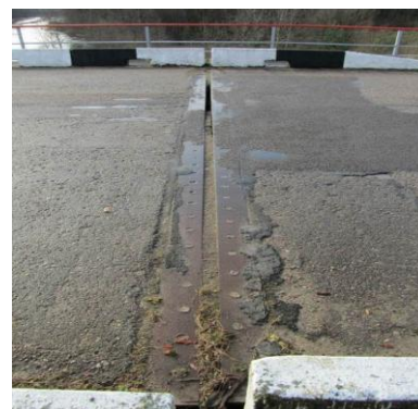
3 pav. Metalinis 150 mm. deformacinis pjūvis. Šaltinis: https://structum.lt/innovatyvi-tiltu-inzinerija-siuolaikines-tendencijos
