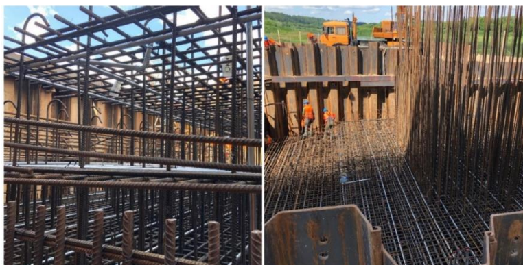
4 pav. Pamato armatūros ir aušinimo vamzdelių išdėstymas prieš betonavimo darbus
