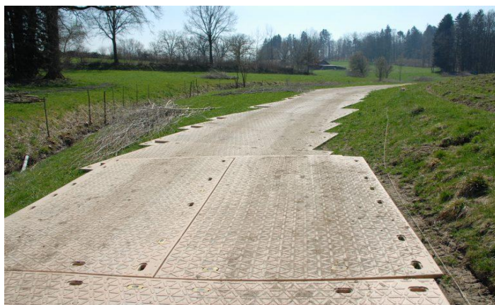
4 pav. Laikino kelio įrengimas panaudojant „Tuff-Trak“ tipo surenkamą dangą Šaltinis: https://www.topra.lt/tufftrak
