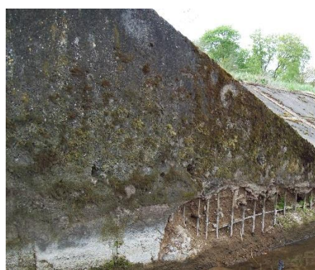
3 pav. Stipriai apirusios gelžbetoninės konstrukcijos Bartkuškio hidromazgo žemutinio bjefo ramtuose
