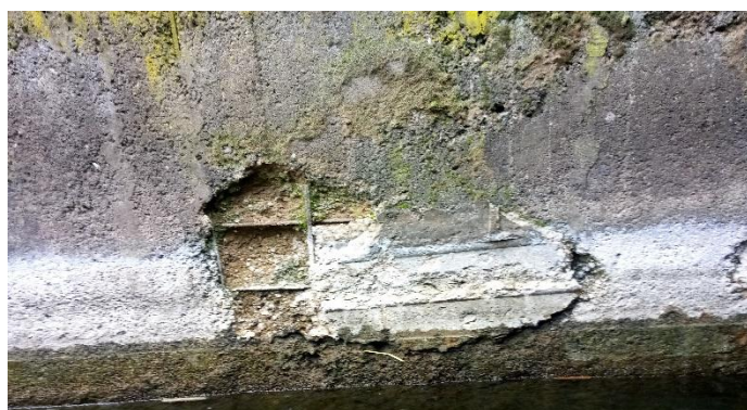
3 pav. Stipriai apirusios gelžbetoninės konstrukcijos Bartkuškio hidromazgo žemutinio bjefo ramtuose
